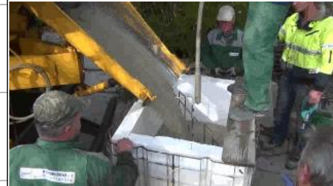
Wypełnianie formy 3D betonem
